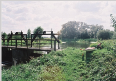
713,2 Jaz w Skrzydlowie
