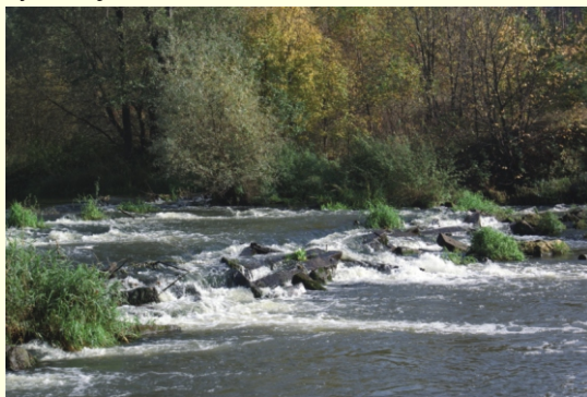
Zniszczony próg wodny PKP w Ważnych Młynach (681,9)
