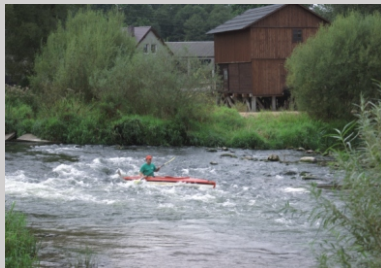
600,4 Zniszczony próg młyna Kępowizna
