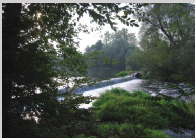
588,7 Próg wodny w Kamionie
